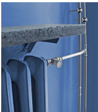
5. Montaż gałązek grzejnikowych
