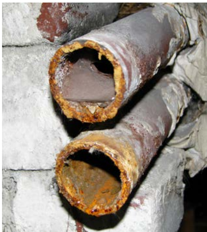
1. Demontaż starej instalacji
