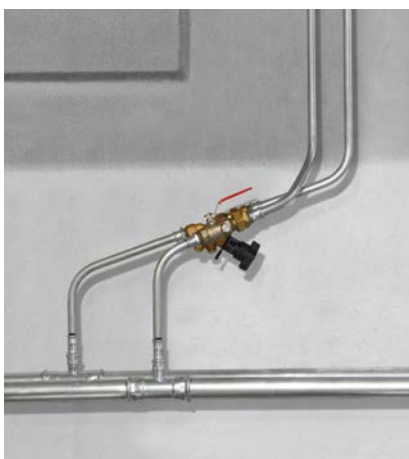
4. Wykonanie podejść i pionów
