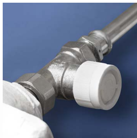
6. Próba ciśnieniowa, regulacja, izolacje termiczne
