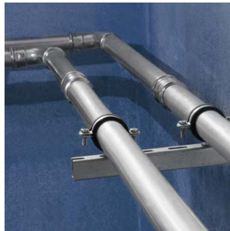
3. Montaż poziomów w piwnicach
